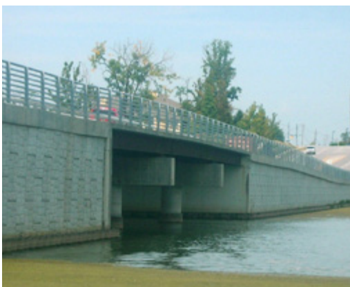
Olio Bridge (USA)
